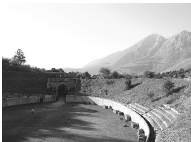
Fig. 7. Vue de l'amphithéâtre fortement restauré.
