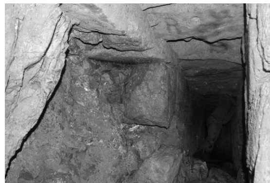
Fig. 27. Diverses petites arrivées d'égouts secondaires dans les collecteurs. Les dalles de couvertures et blocs des parois ont été taillées pour recevoir ces égouts.
