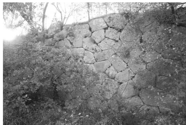
Fig. 4. Une section de l'enceinte d'Alba en appareil polygonal.
