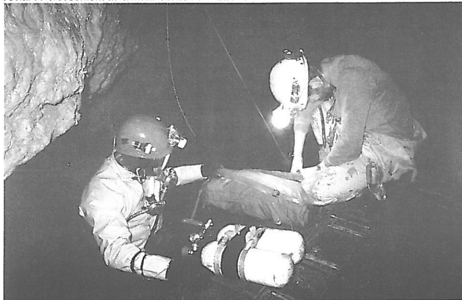
Préparatifs à la plongée du siphon; on distingue au-dessus de l'eau le "pont avec les rails" pour le déblai du creusement au tunnel. Cliché F. Guinand.
